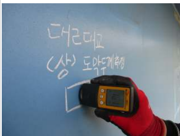
거더 외부 도막두께 측정
