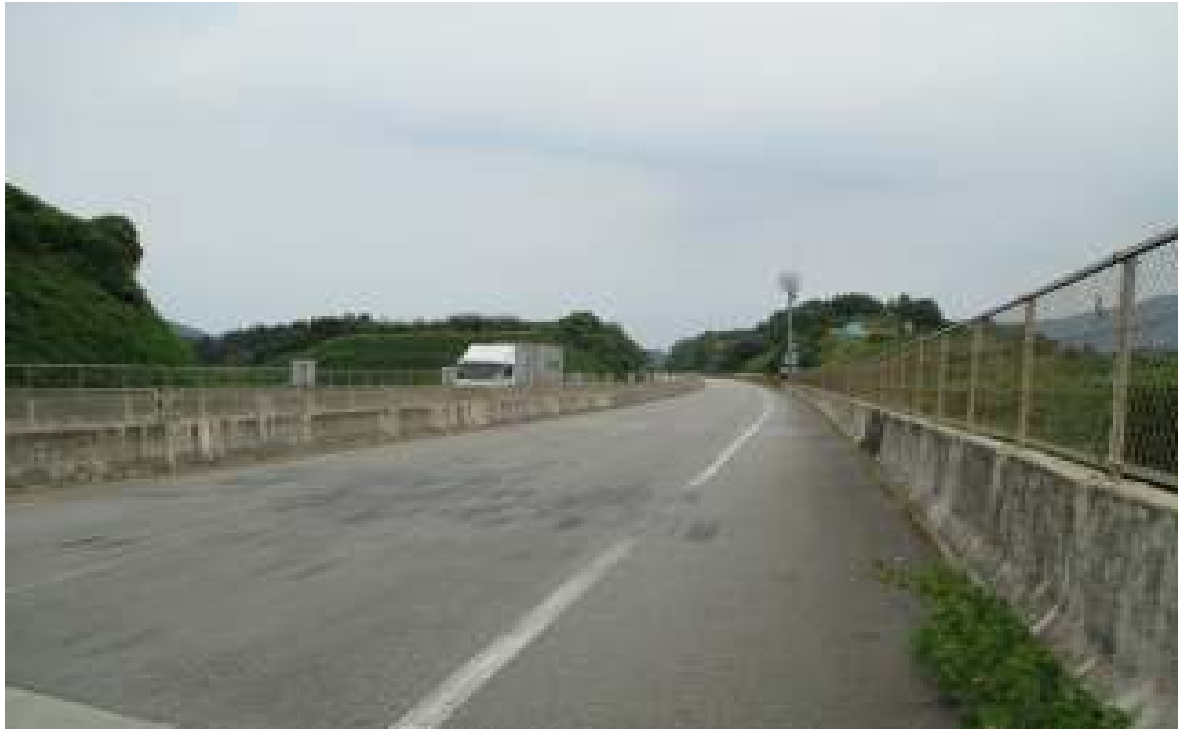
교량 상부 전경
