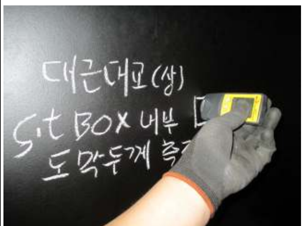
거더 내부 도막두께 측정
