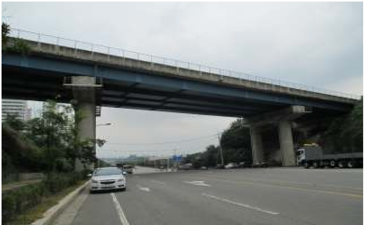
교량 측면 전경
